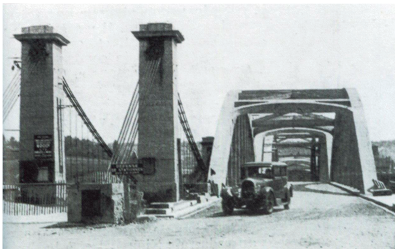
Les deux ponts côte à côte
