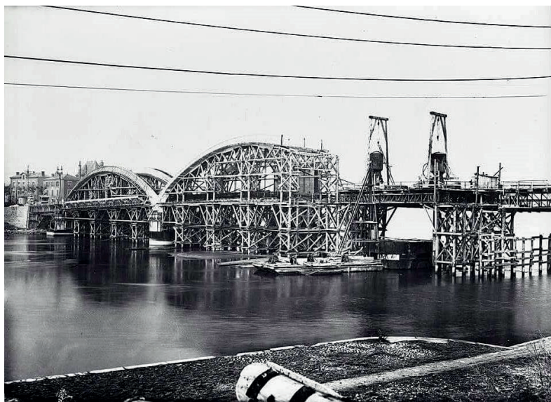
La construction du pont
